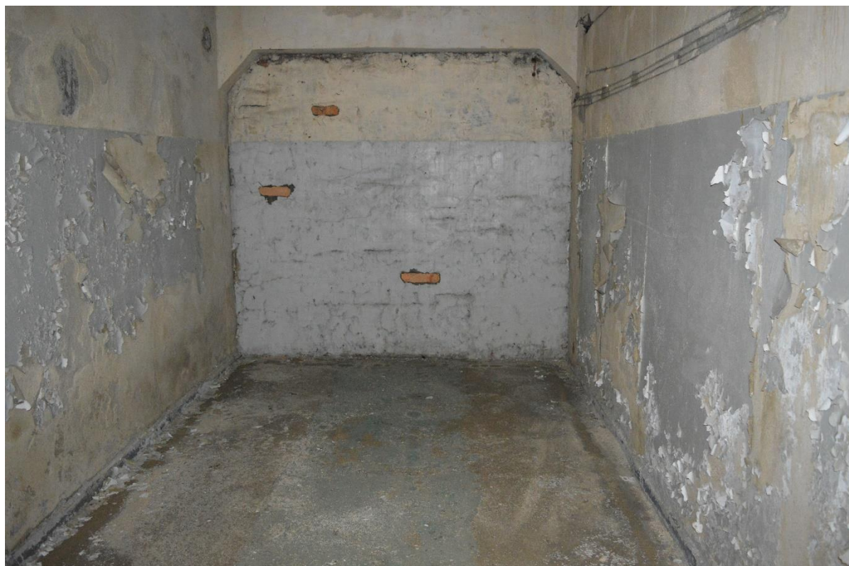
Zdjęcie nr 10 – widok na istniejący korytarz przy ścianie zewnętrznej piwnicy.
